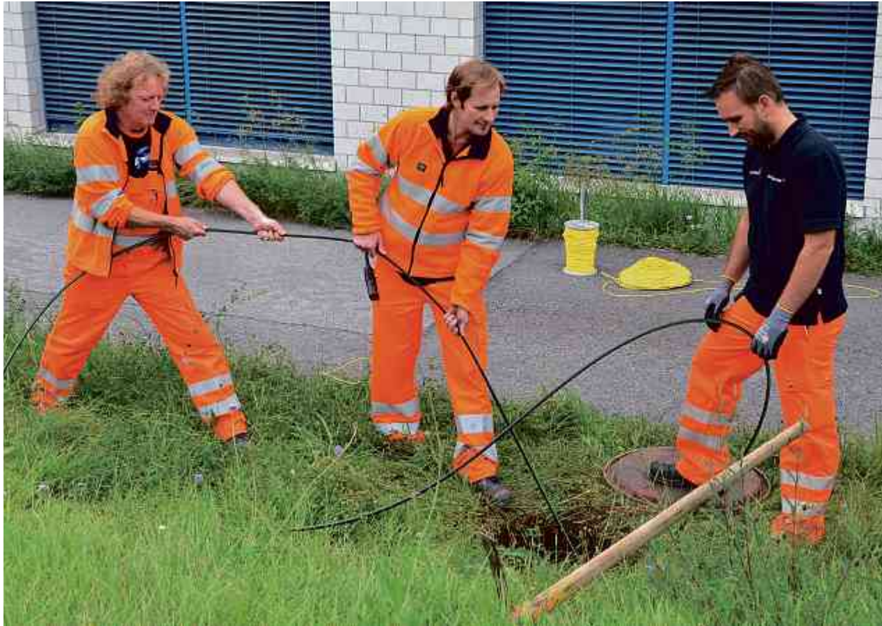
Die Gemeindeelektriker verlegen das Hochleistungskabel zum Anschluss des Rheinunternehmens
