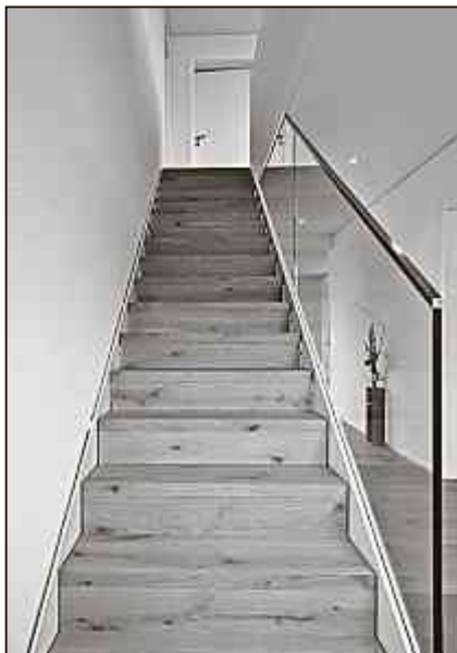
Die Treppe aus Massivholz ist mit einem Geländer aus Glas konzipiert.
