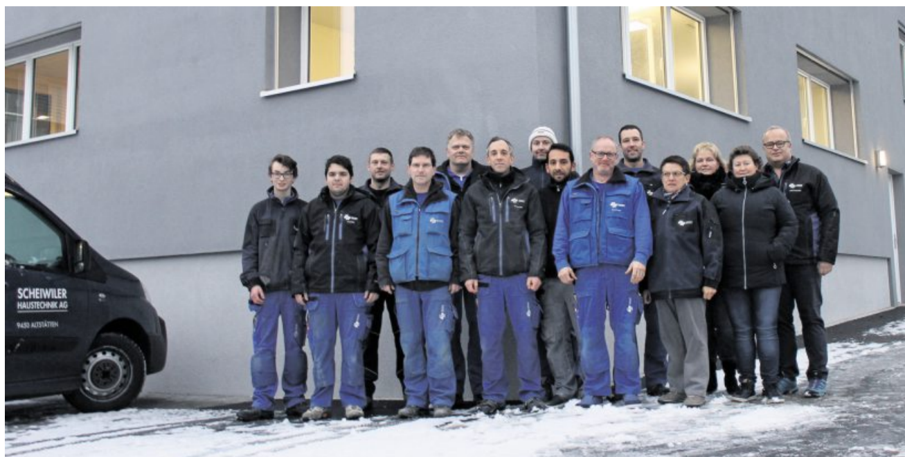
Der Umbau des «Pächterhauses» ist abgeschlossen. Drei Wohnungen sind entstanden, die noch vor dem Jahresende bezogen werden
