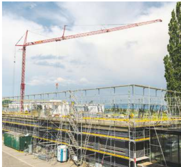
Die ersten Holzelemente werden platziert.
