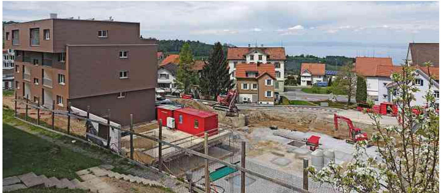
Links: Haus 2 fertiggestellt. Rechts: Haus 1 und 3 im Bau.
