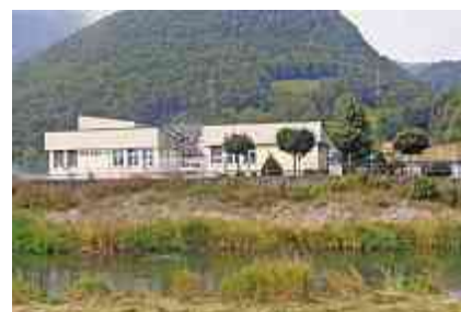
Sanierung und Erweiterung ARA Hirschen-sprung, Rüthi
