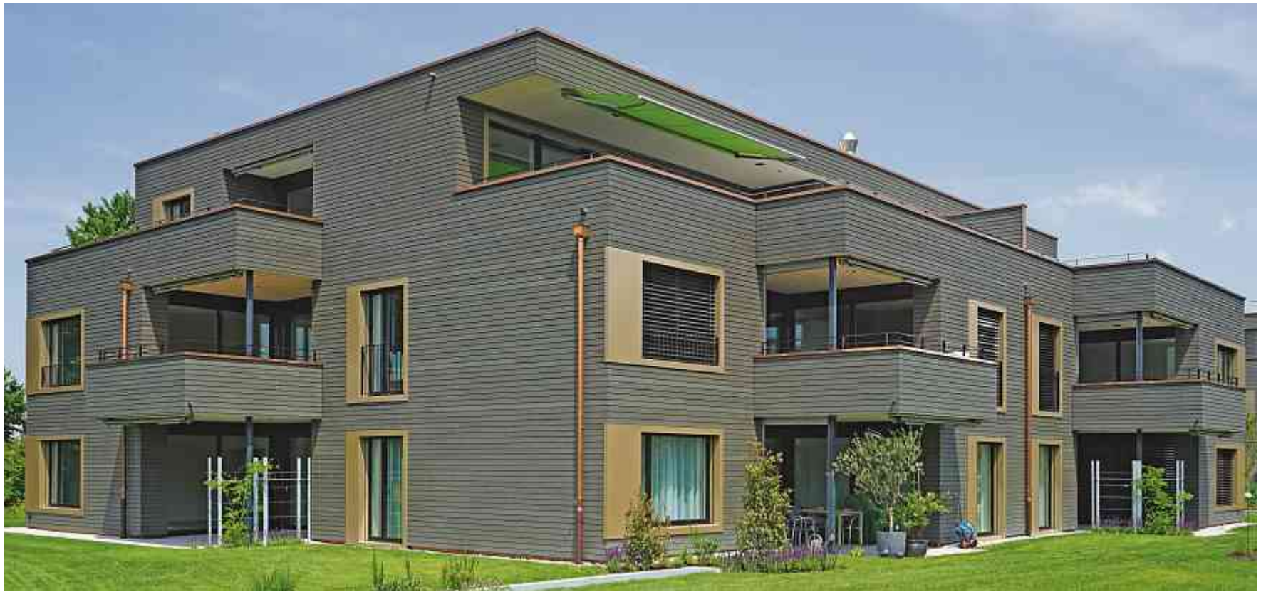
Haus A von Südwesten.
