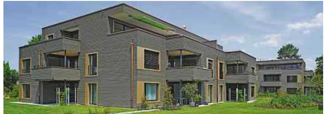
Häuser A und C von Südwesten.
