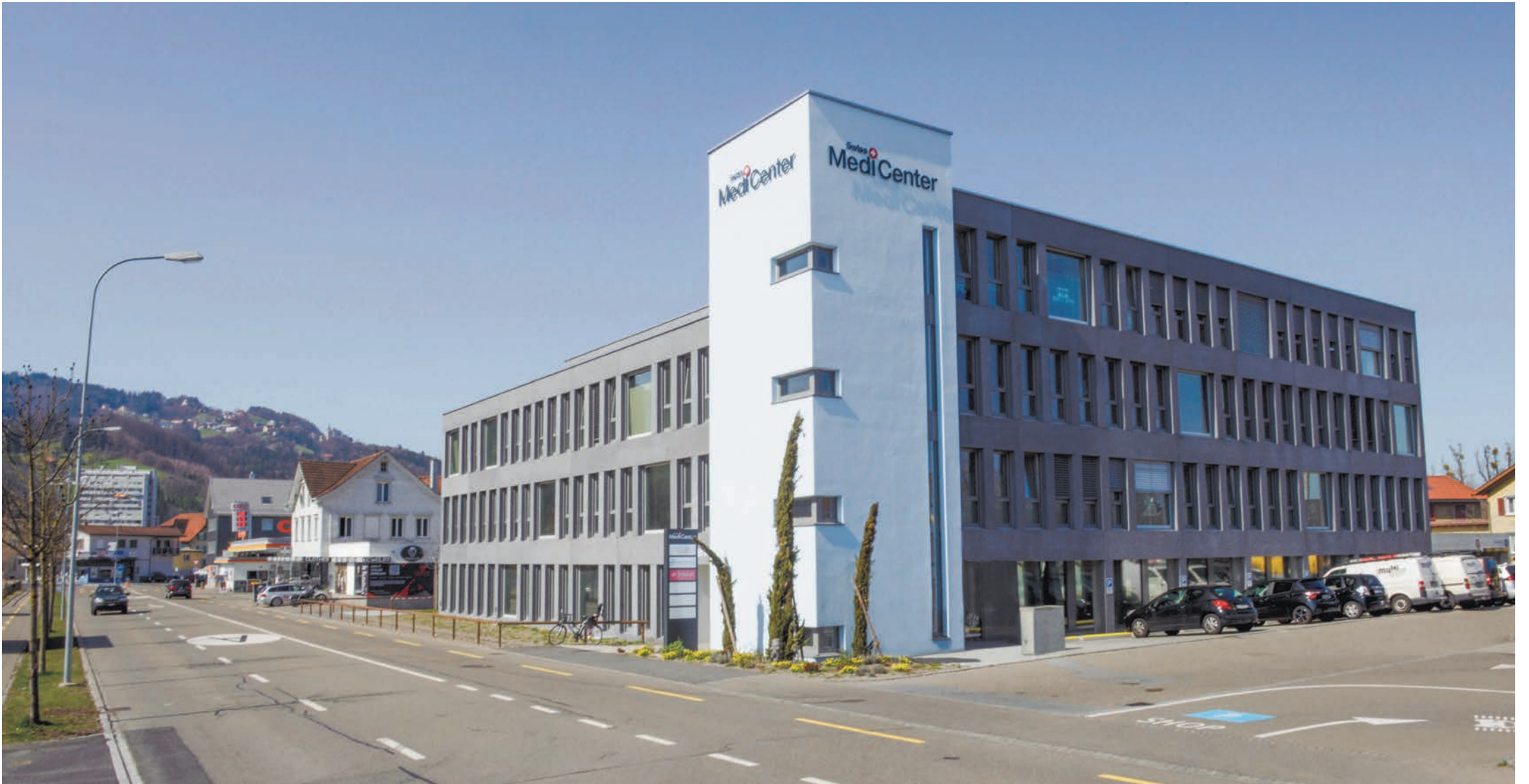
Im Swiss MediCenter in St. Margrethen sind bereits verschiedene spezialisierte Praxen ansässig und weitere werden dazukommen.
